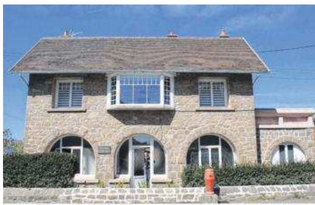
La bâtisse de la rue Aristide-Briand a été rénovée l'année dernière.
